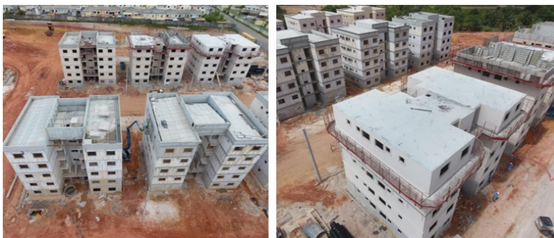
Figura 2: Canteiro de obras no qual a coleta de dados foi realizada
