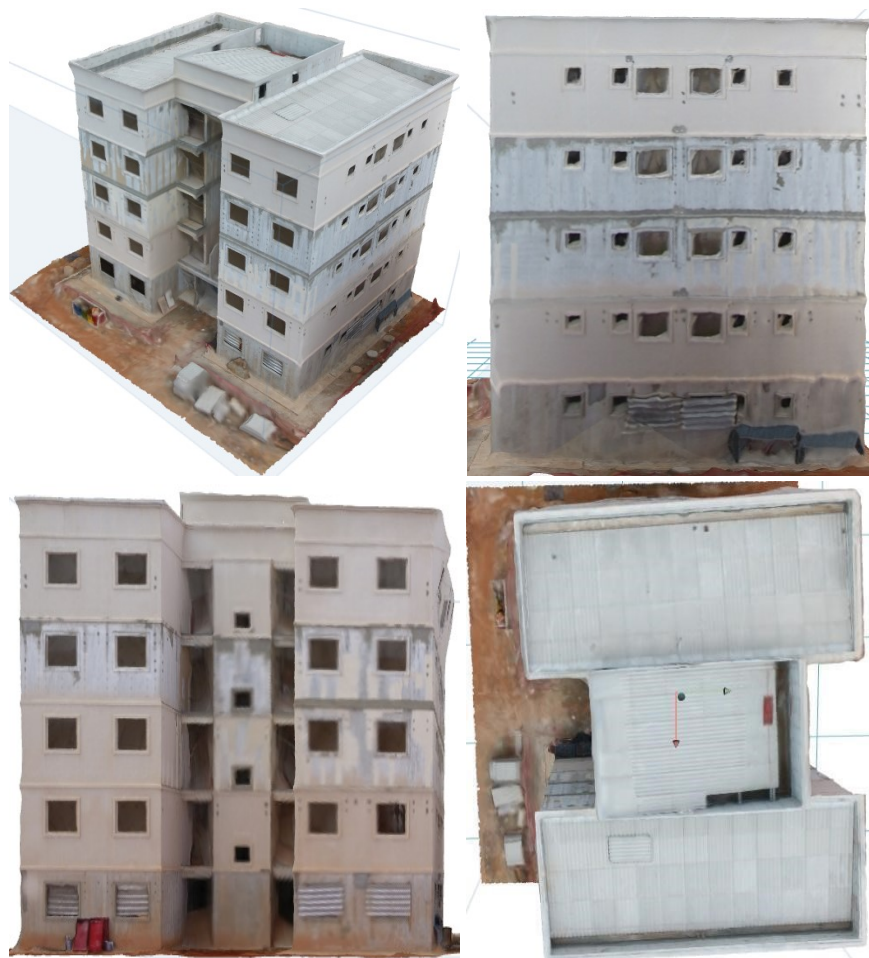
Figura 6: Modelo gerado no Recap por fotogrametria com diferentes vistas: geral (à esquerda acima); fachada I (à direita acima), fachada II (à esquerda abaixo) e cobertura (à direita abaixo).
