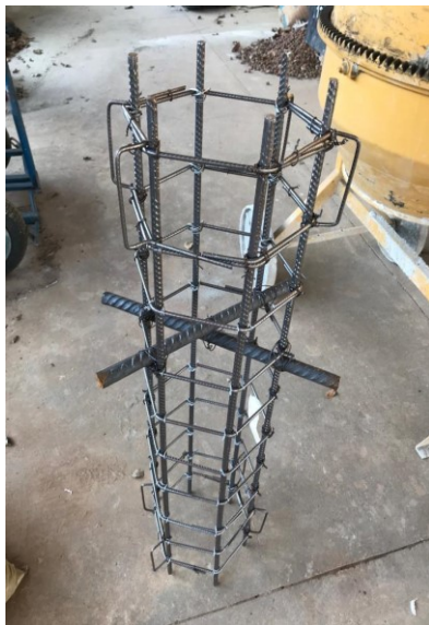
Figura 1: Armadura utilizada nas estacas tipo broca
