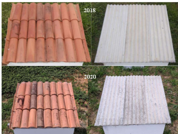
Figura 4: Estado das coberturas em 2018 (acima) e 2020 (abaixo).
