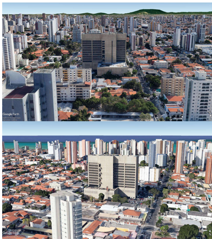
Figura 8: Fachada norte-nordeste (acima) e fachada sul-sudeste (abaixo)
