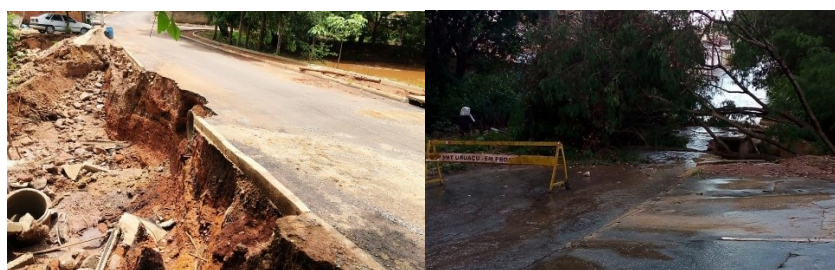
Figura 2: Deslizamento de terra nas proximidades do lago no Parque dos Buritis, no Setor Sul I, em Uruaçu – GO.
