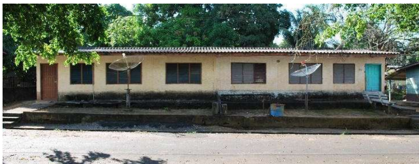
Figura 4: Fachada da habitação geminada
