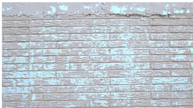
Figura 6: Textura nas paredes
