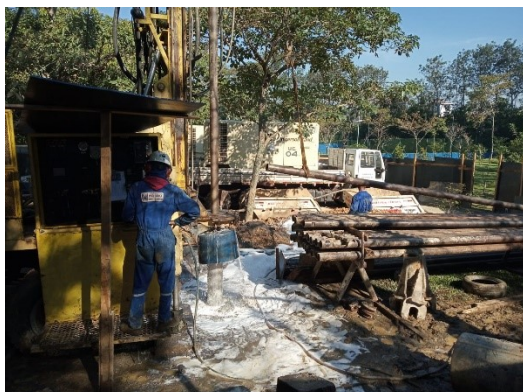
Figura 5: Perfuração Poço P11.
