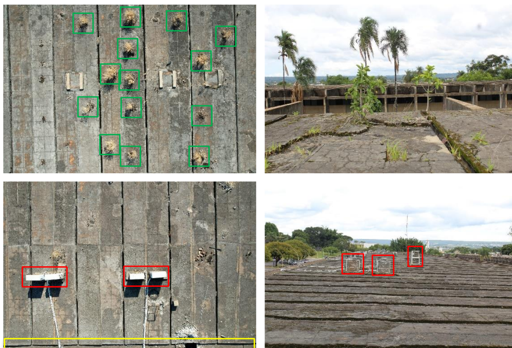
Figura 6: Presença de vegetação invasiva, indicada em verde, na cobertura do Instituto Central de Ciências da Universidade de Brasília (vista aérea acima e à esquerda; vista do observador acima e à direita), e carcaça de equipamentos obsoletos em desuso, indicados em vermelho, e fechamento da viga calha, em amarelo (vista aérea abaixo e à esquerda; vista do observador abaixo e à direita).
