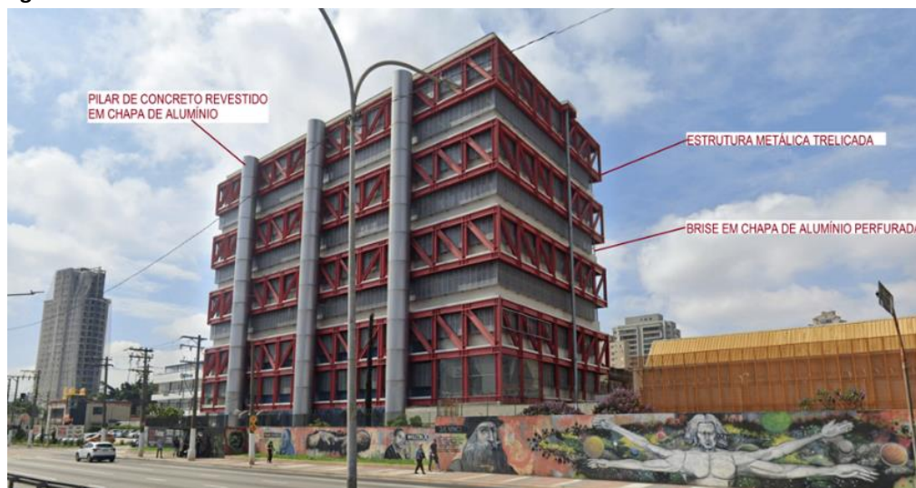
Figura 1: Edifício da FATEC Victor Civita
