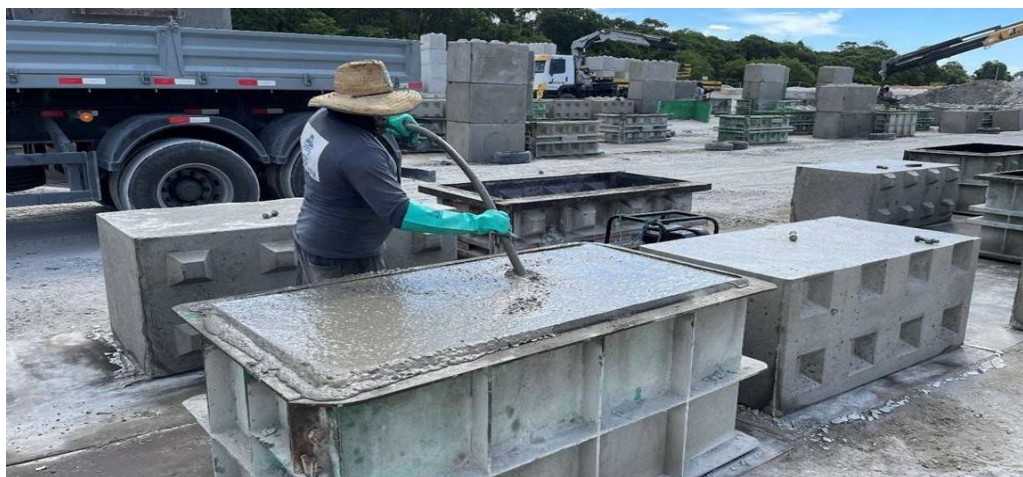
Figura 7 – Vibração do concreto lançado nas formas
