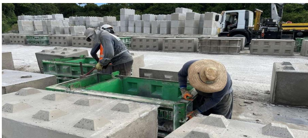
Figura 6 – Montagem das formas metálicas para fabricação dos blocos maciços
