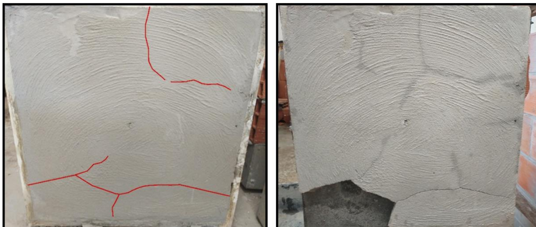
Figura 4: Revestimento de argamassa mista: após cura, com fissuras de retração (à esquerda); após ciclos térmicos, com fissuras maiores e deslocamento (à direita)
