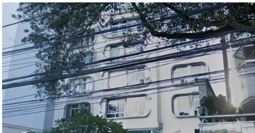
Figura 2: Sombreadores do edifício Comodoro
