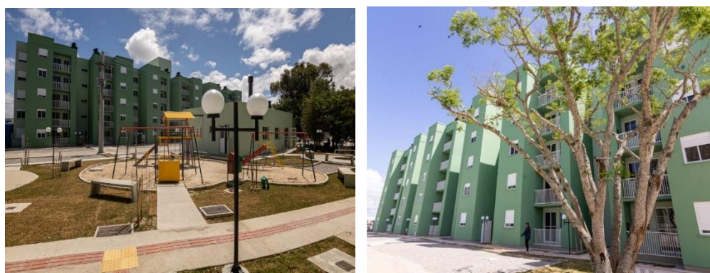
Figura 2: Visão geral do empreendimento (à esquerda); Fachada do objeto de estudo (à direita).
