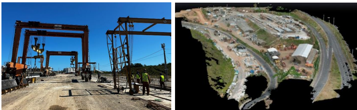
Figura 2: Pátio de grande extensão de uma obra de infraestrutura (à esquerda); MDS (à direita)
