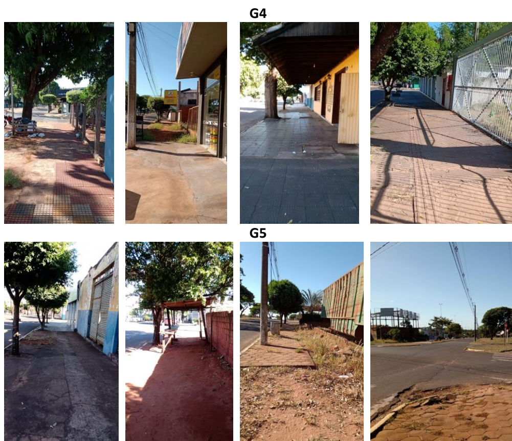
Figura 05: Características das calçadas do G4 e G5
