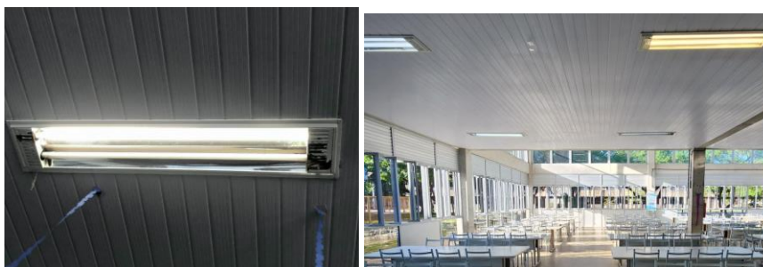
Figura 3: Modelo de luminária utilizada no RESUN (à esquerda); Cena interna que mostra as diferenças de temperatura de cor entre as lâmpadas (à direita);
