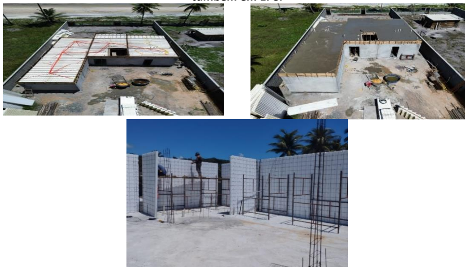
Figura 1: As imagens demonstram a vista superior da edificação com montagem da laje também em EPS.
