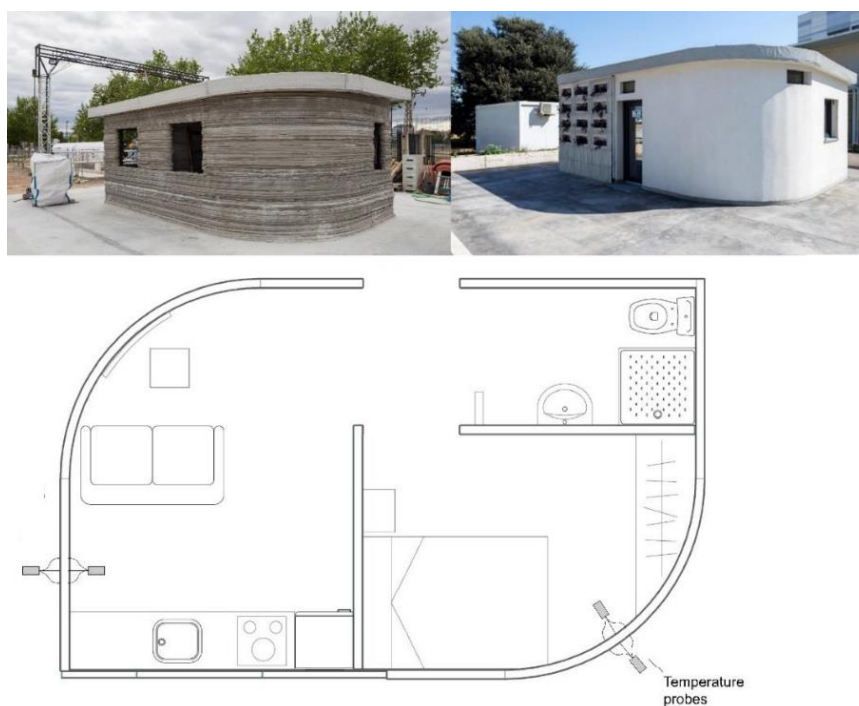
Figura 13: Casa com e sem acabamento e planta baixa com os dispositivos de medição
