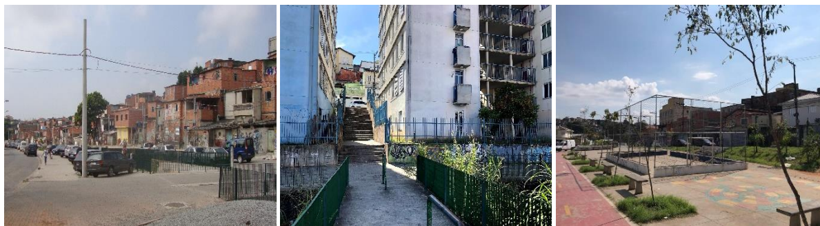
Figura 6: Aumento da impermeabilização, descontinuidade de áreas públicas e tamponamento do córrego, condições que romperam com a 2ª fase do Parque Linear do Sapé.
