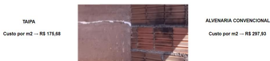
Figura 12: Comparativo entre taipa e alvenaria convencional
