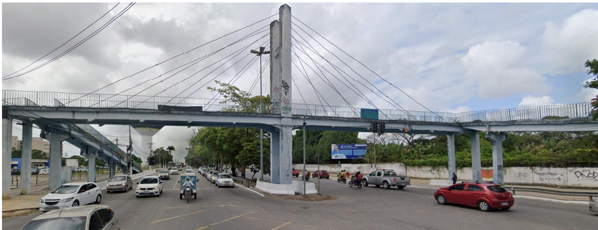
Figura 2: Passarela localizada na BR-104 em Maceió-AL.
