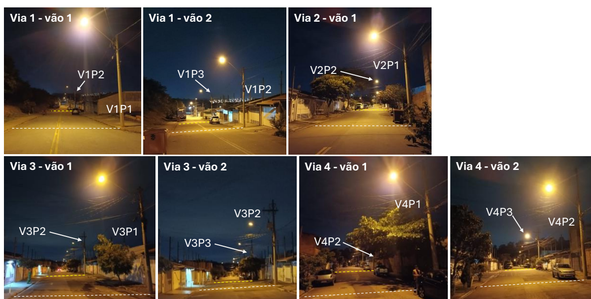
Figura 3: Vias no momento das medições estáticas e dinâmicas. Na ordem apresentada, Vias 1, 2, 3 e 4, com o Poste 1 do vão mais próximo da imagem e o Poste 2 mais distante (na posição das setas).
