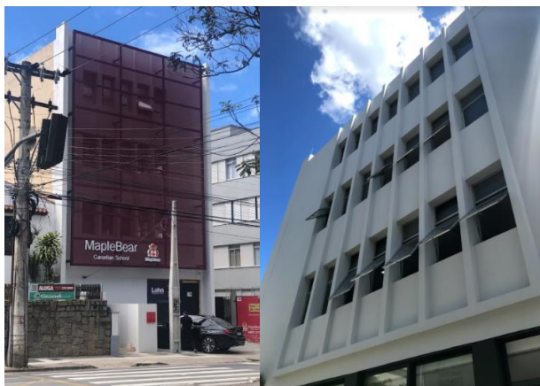
Figura 11: Baixa absorvância solar nas paredes externas. Fachada frontal (à esquerda); fachada lateral sul do Bloco A (à direita)
