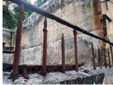
Figura 20 - Vista grade de ferro
