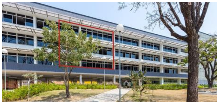
Figura 2: Fachada Norte e salas de estudo
