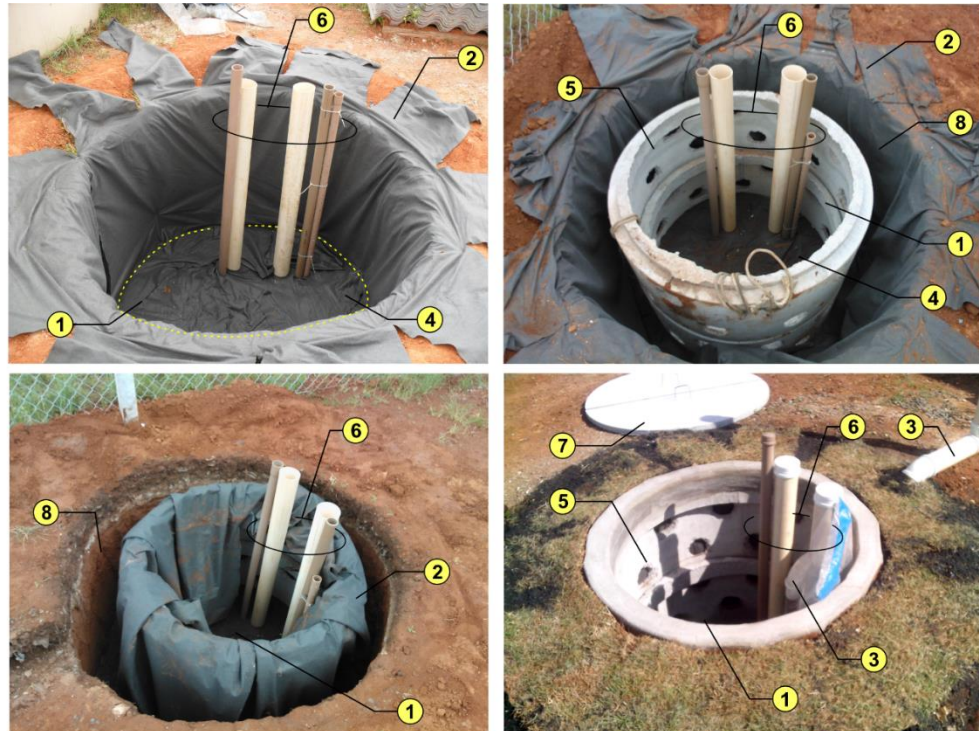
Figura 2: Poços de infiltração monitorados no ensaio de rebaixamento de nível de água para a comparação com os diferentes ensaios de determinação das taxas de infiltração
