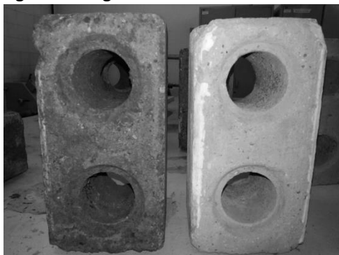
Figura 1: Imagem de amostras de blocos de solo-cimento retirados do local das edificações.
