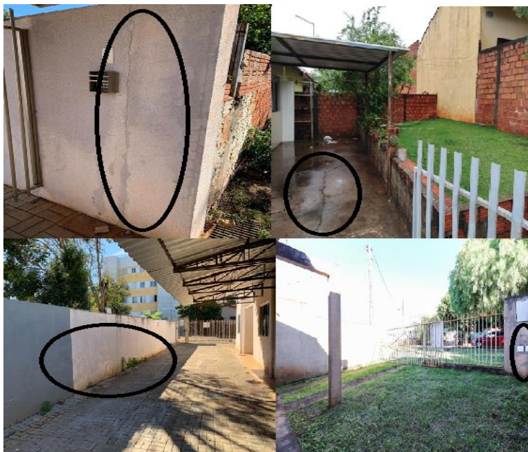
Figura 6: Fissuras/rachaduras externas
