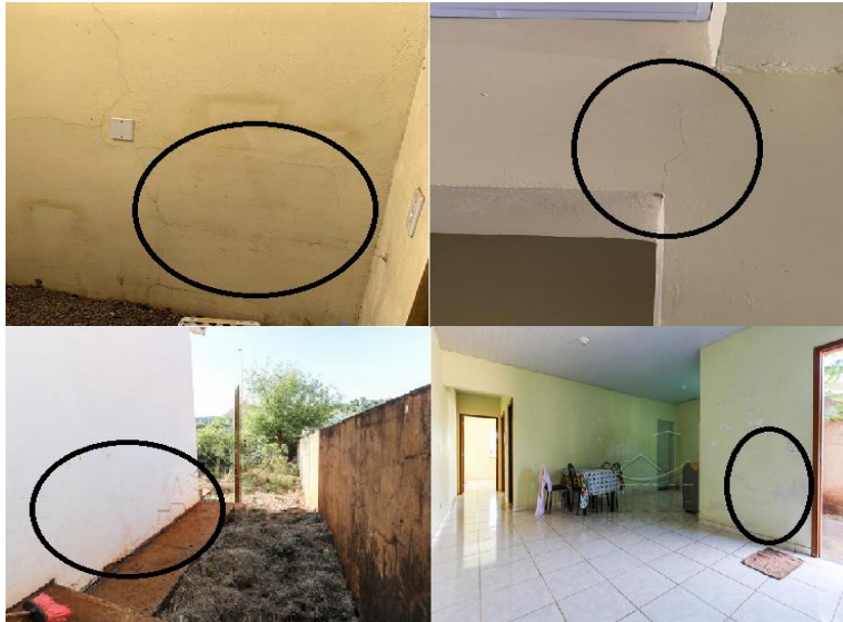
Figura 5: Fissuras/rachaduras internas
