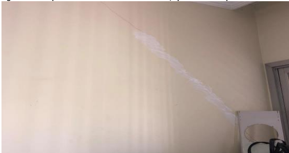
Figura 6 - Vista parcial interna da alvenaria da suíte/apartamento superior.
