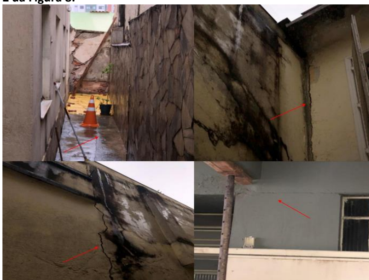
Figura 10 – Evidências do recalque diferencial em direção a divisa posterior padaria no local 2 da Figura 8.
