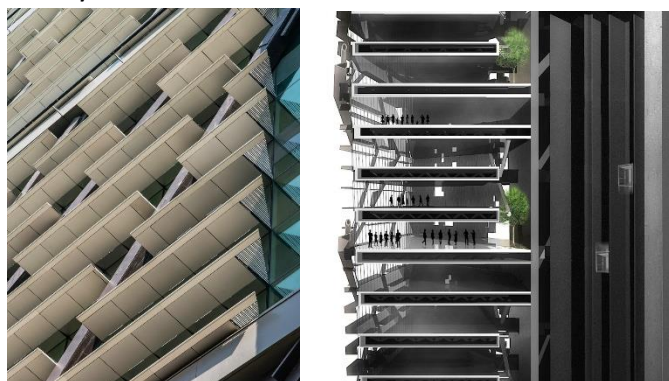
Figura 9 e 10: Sombreamento horizontal da fachada (à esquerda) e corte esquemático (à direita).
