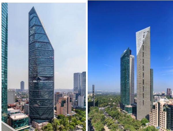
Figura 6 e 7: Fachadas principais da Torre Reforma.
