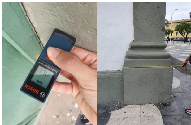
Figura 6: Coleta de medidas de elementos de referência da edificação
