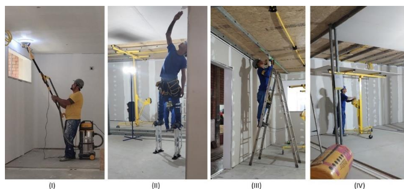
Figura 6: Novas ferramentas incorporadas à atividade de Drywall
