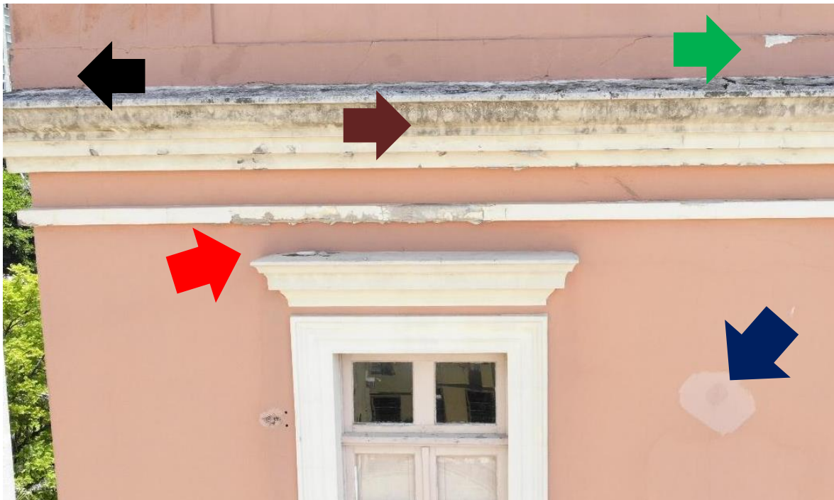
Figura 12 - Foto do drone com exemplos das manifestações patológicas
