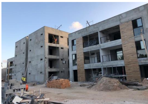
Figura 2: Canteiro de obras – unidade de análise da pesquisa
