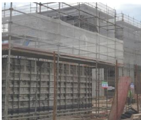
Figura 4: Andaime fachadeiro utilizado na obra
