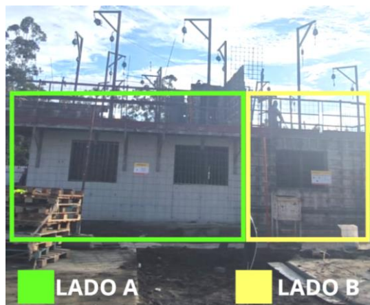
Figura 5: Montagem do EPC em diferentes estágios
