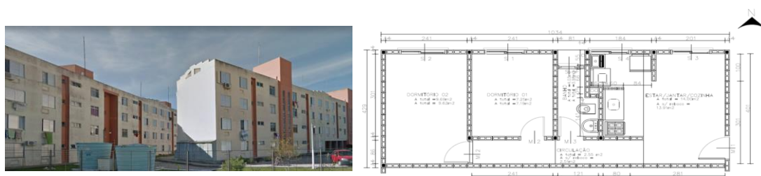
Figuras 3 e 4 – Vista do conjunto habitacional e planta baixa do caso base
