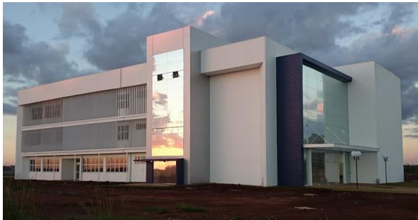
Figura 1 - Vista da fachada Oeste, Edifício V2, 2015.
