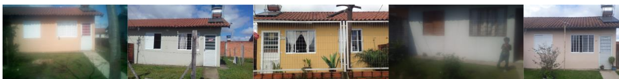
Figura 2 – Fachada das habitações unifamiliares escolhidas
