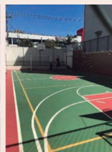
Figura 2. Quadra esportiva sobre reservatório moldado in loco
