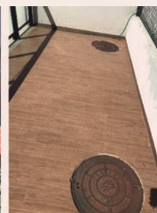
Figura 3. Casa de bombas
