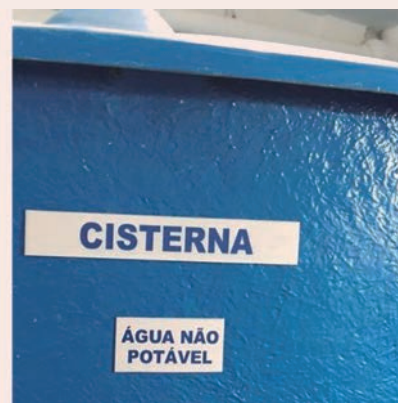
Figura 5. Identificação da potabilidade da água no reservatório: edifício N.
