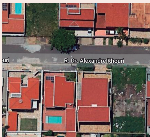
Figura 5. Laje descoberta (Parque Oziel) Foto Leda Nishimura)
