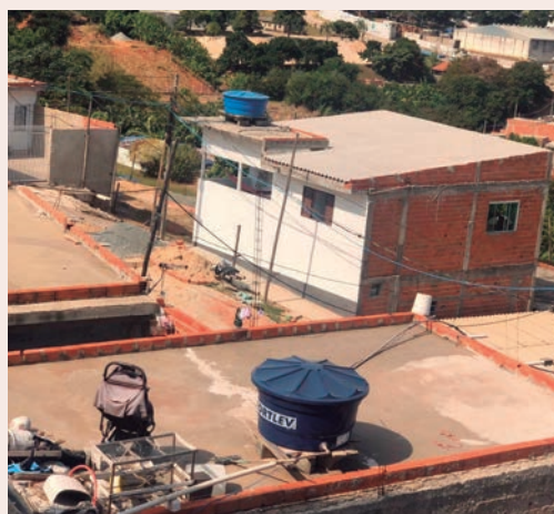
Figura 6. Alto Taquaral piscina sem tratamento e entulho em lote ocioso.
