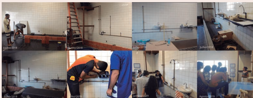
Figura 2. Etapas de construção e início de operação da Parede Hidráulica Experimental - LabHidro-FAU/UFRJ em 2018.
