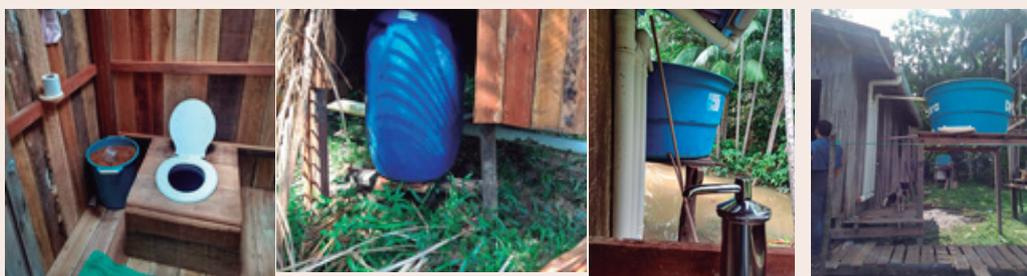
**Figura 3.** Banheiros secos e captação de água de chuva. Ilha das Onças, Belém - PA.
