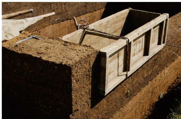
Figura 1. Fôrma de madeira tradicional
