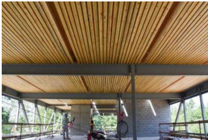
Figura 1. Paneles de DLT utilizados como entrepiso.
