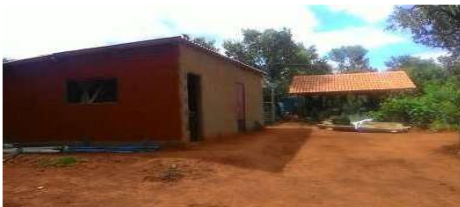
Figura 5. Residência parcela 16 construída usando as técnicas de Taipa de mão, COB, Superadobe, Taipa de pilão e Adobe.
