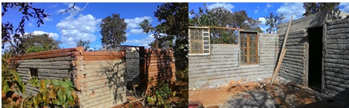
Figuras 6 e 7. Uma casa sendo construídas com Hiperadobe na parcela, 11 do Assentamento Pequeno Willian, Planaltina – DF.
