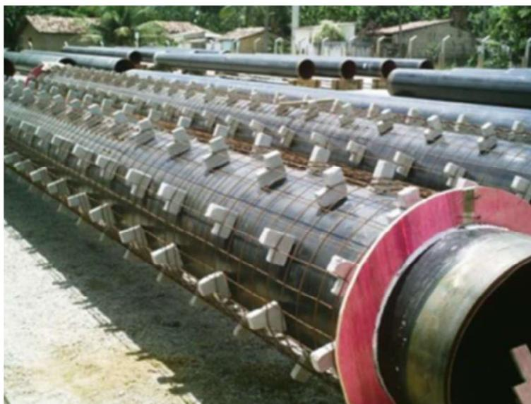
Figura 9 - Tubo com armadura convencional, Emissário do COMPERJ
