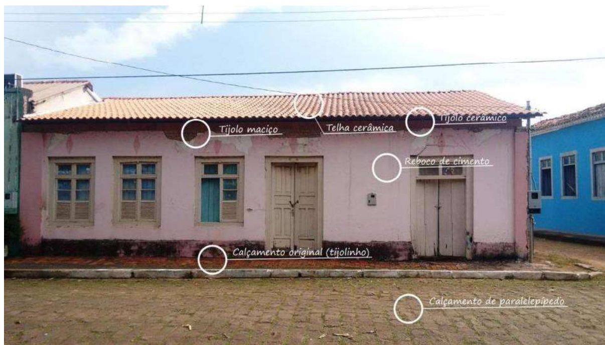
Figura 2: identificação de materiais adicionais às construções de adobe (crédito: Nátali de Paula, 2018)
