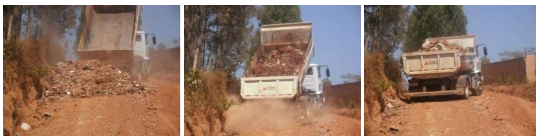
Figura 1. Uso de RCC na manutenção de estradas rurais.
