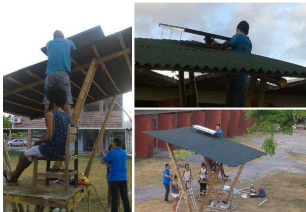
Figura 6. Instalação do módulo fotovoltaico
