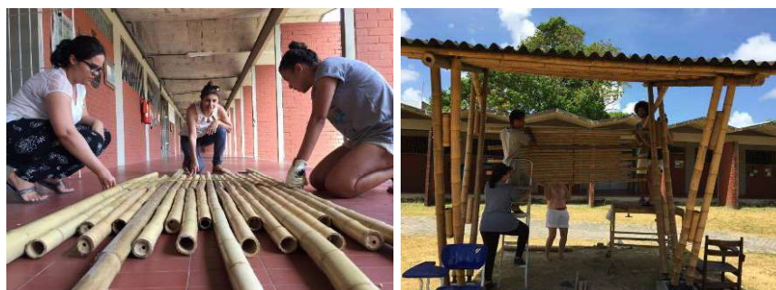
Figura 5. Processo de montagem e instalação do brise.
