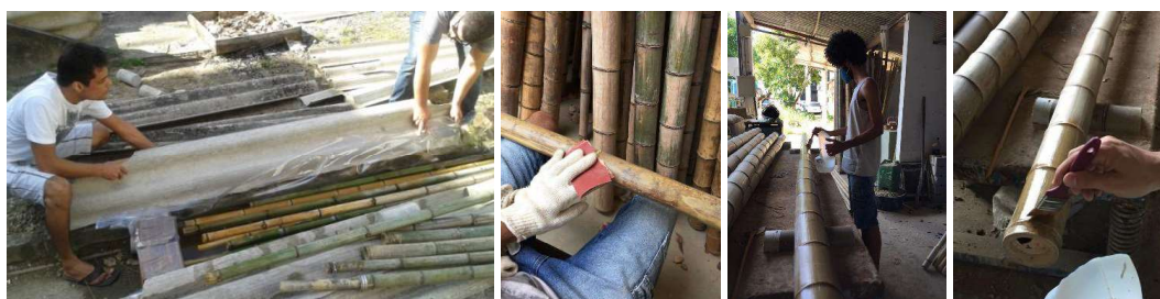
Figura 3. Tratamento químico, lixamento e aplicação do fundo preparador no bambu.
