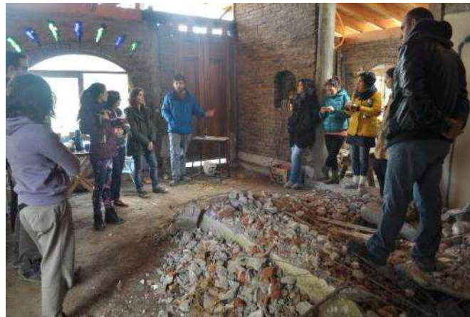
Figura 6. visita de obra
